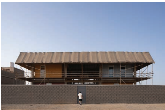
مرکز بی‌الگو (متغیر)، ساختمانی دو طبقه با عملکرد آموزشی، شامل فضای زندگی و کارگاه‌ها می‌شود. این سازه با فناوری ساده و با بتن، سیمان و داربست، با استفاده از دانش فنی محلی ساخته شده و توسط یک سقف سایبانی پوشش داده شده است. این مرکز می‌تواند برای نیازها و کاربری‌های متفاوت، بازاریابی گردد.
