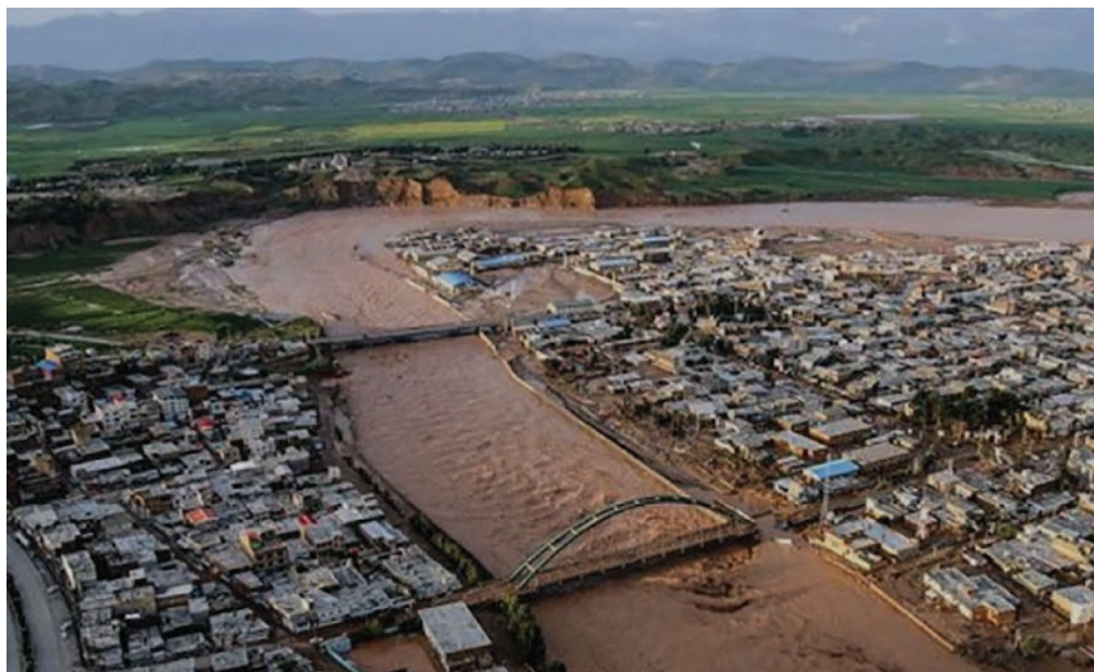
تصویر: پلدختر در استان لرستان، یکی از شهرهایی بود که در سیل سال ۱۳۹۸ آسیب فراوانی دید. در این عکس بخش غربی و نوساز شهر بدلیل تجاوز به حریم سیل خیز رود کشکان، بیشترین خسارت را متحمل شد.
